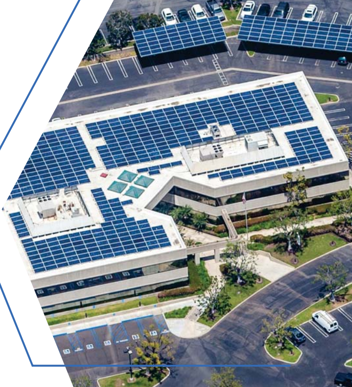
Geração em cobertura
